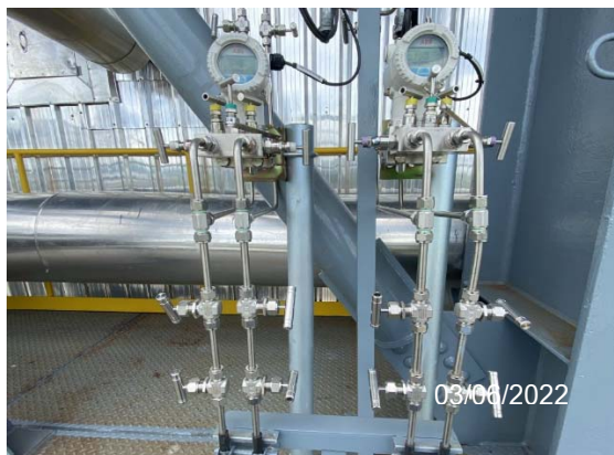
รูปที่ 77 อุปกรณ์ตรวจวัดอัตราการไหล ของหม้อไอน้ำ
