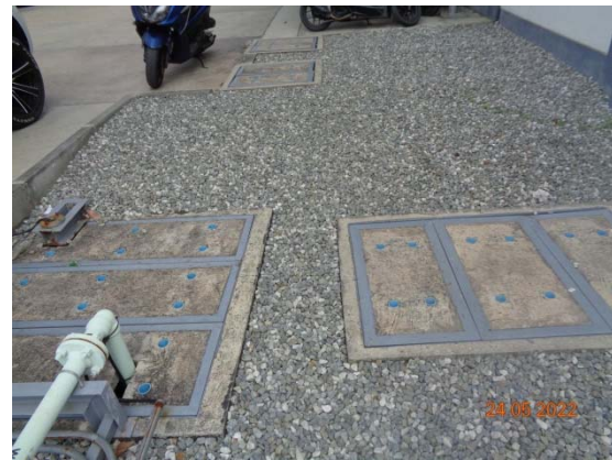
รูปที่ 30 ถังบำบัดน้ำเสียสำเร็จรูปขนาด 5 ลูกบาศก์เมตร
