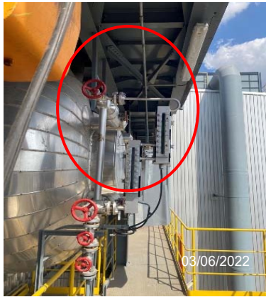
รูปที่ 79 อุปกรณ์ตรวจวัดระดับน้ำของหม้อไอน้ำ
