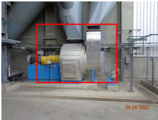
รูปที่ 18 พัดลมดูดอากาศ (Primary Air Fan) ของบ่อรับกากอุตสาหกรรม และภายในอาคารรับกากอุตสาหกรรม
