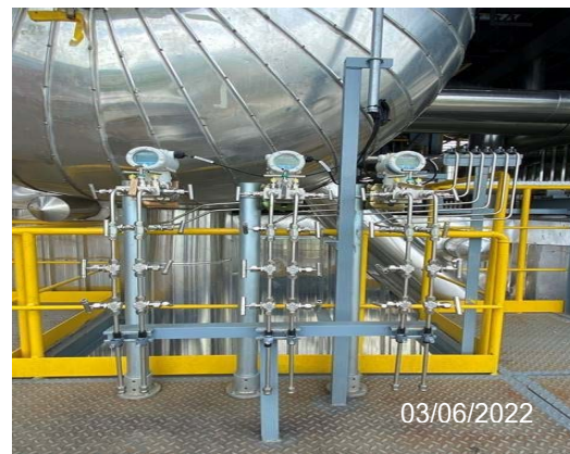
รูปที่ 76 อุปกรณ์ตรวจวัดความดันของหม้อไอน้ำ
