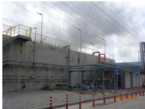
รูปที่ 23 ถังสำรองน้ำดับเพลิง ขนาด 400 ลูกบาศก์เมตร
