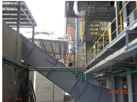
รูปที่ 56 ระบบลำเลียงเถ้าที่เป็นระบบปิด
