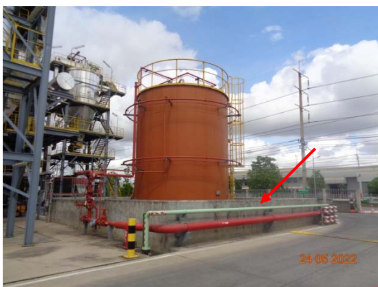
รูปที่ 42 คันคอนกรีตรอบถังเก็บสำรองน้ำมัน
