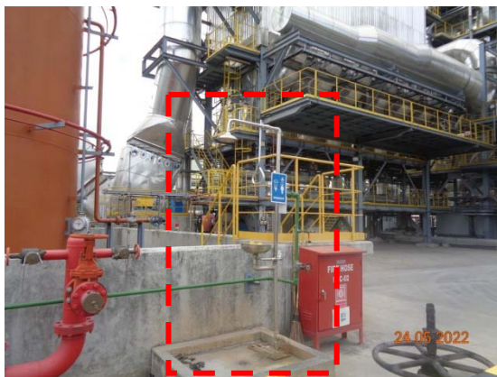
รูปที่ 75 ฝักบัวฉุกเฉินและอ่างล้างตา บริเวณพื้นที่เก็บสารเคมี
