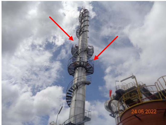
รูปที่ 11 จุดตรวจวัดมลพิษก่อนระบายออก ของปล่อง Boiler (CEMs)
