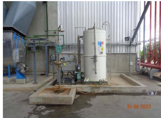
รูปที่ 6 ระบบ SNCR
